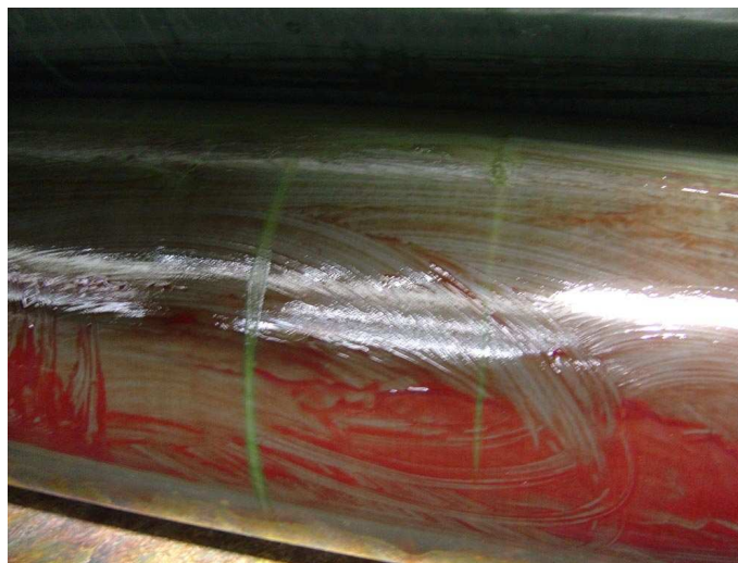
PREPARAT RECYL COBRA W TRAKCIE USUWANIA KOLEJNYCH POZOSTAŁOŚCI FARB
